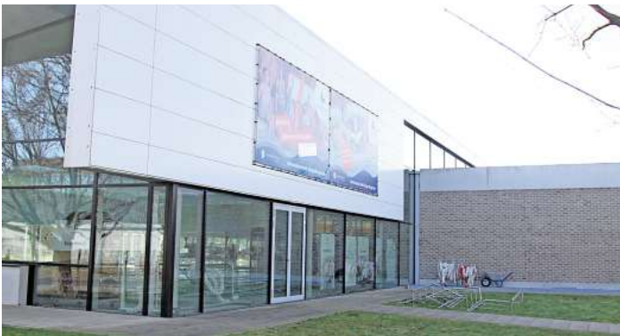
Hat die Eintrittspreise zum 1. Januar 2025 erhöht: Die Wasserwelt Langenhagen. Foto: Stephan Hartung
