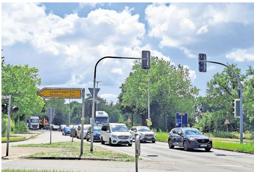
Sperrung von Juli bis Dezember 2026: Die Stadt erneuert die Langenhagener Straße von der Kreuzung zur Anschlussstelle Engelbostel (A352) bis Alt-Godshorn. Foto: Gerko Naumann
