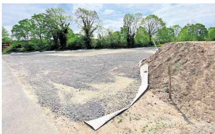
Mutterboden zusammengeschoben: Folie und Schotter schützen Grundstück Im Gleisdreieck, auf dem die Deutsche Bahn für die Sanierung der Strecke Hannover - Hamburg Material lagern will. Foto: Katerina Jarolim-Vormeier
