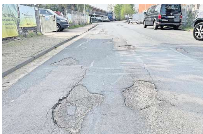
Eine Zufahrt zu den Grundstücken ist im Mühlenfeld während der Bauarbeiten nicht möglich. Foto: Oliver Krebs
