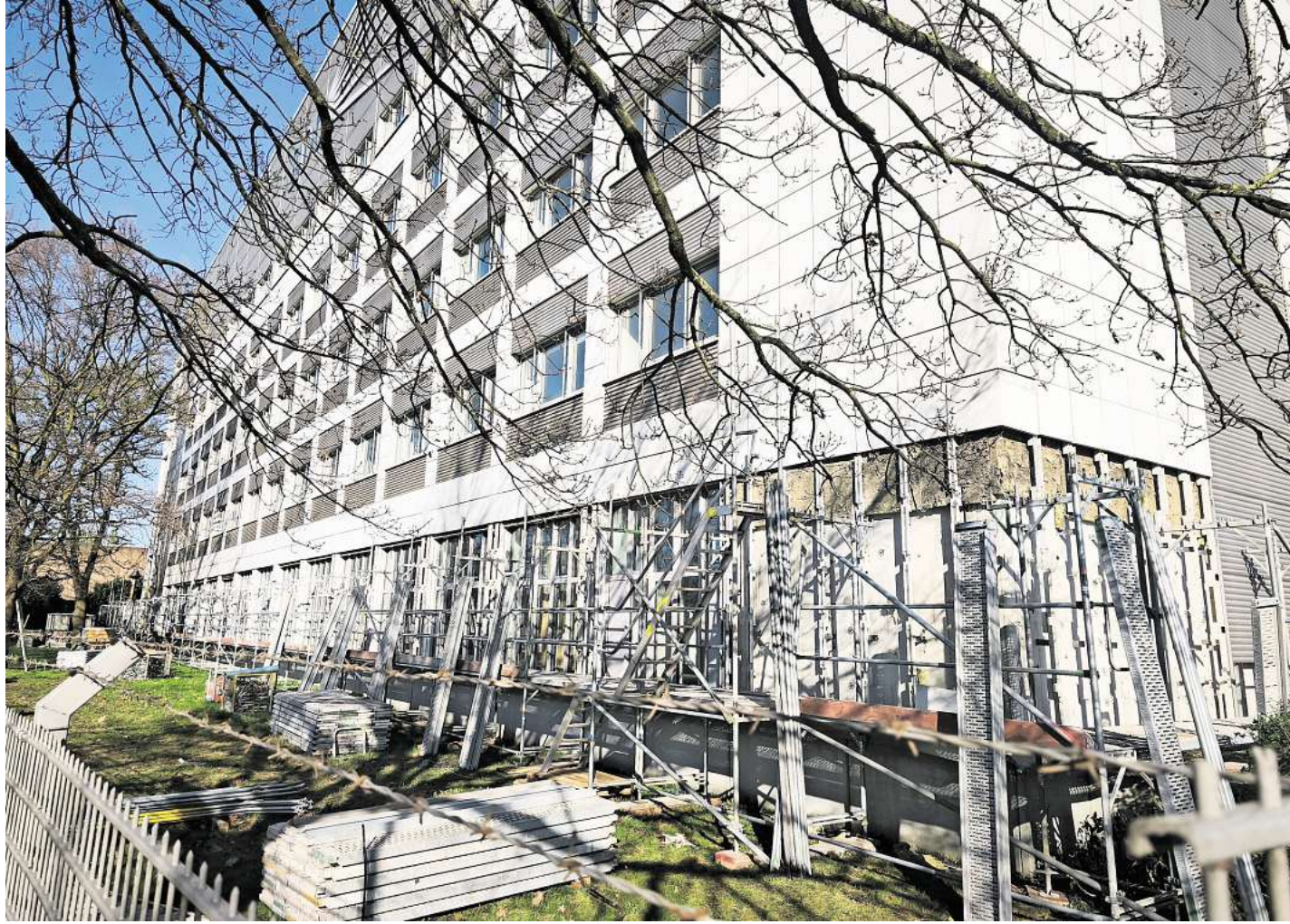
Trotz Widerstandes: Die Arbeiten am Bau haben begonnen.
