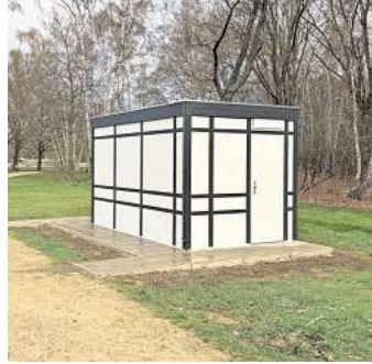
Ergänzung des Toilettenangebotes am Ostufer.
