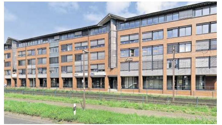
Das Team der EPL ist bald im sogenannten Rexroth-Gebäude zuhause. Foto: privat
