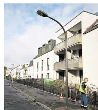
Neue Laternen in der Freiligrathstraße: Alte, rostige Exemplare werden in dieser Woche durch verzinkte Laternenmasten ersetzt. Foto: Mario Moers
