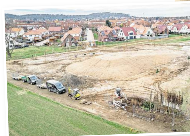
In einem Baugebiet in Gerhden hat das Langenhagener Unternehmen die Außenanlagen angelegt. Foto: Mats Schmidt
