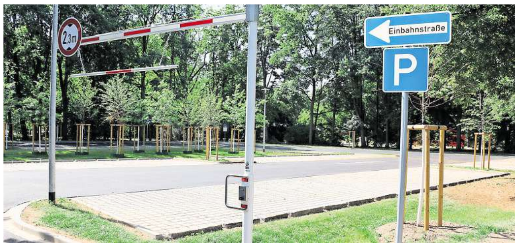
Asphaltiert, begrünt und mit Einbahnstraßenregelung: Der erneuerte Parkplatz soll künftig mehr Stellflächen, Aufenthaltsqualität und Sicherheit bieten. Foto: Ingo Rodriguez
