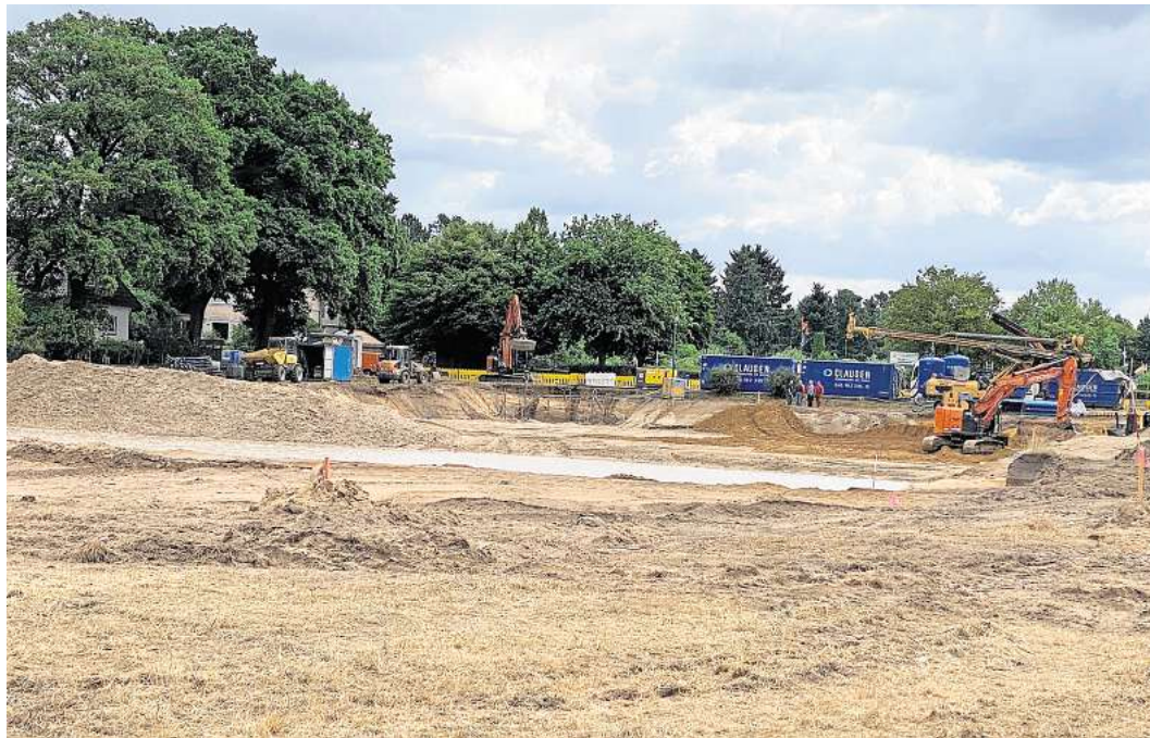
Arbeiten schreiten voran: Die Stadt errichtet an der Leibnizstraße ein Regenrückhaltebecken.
