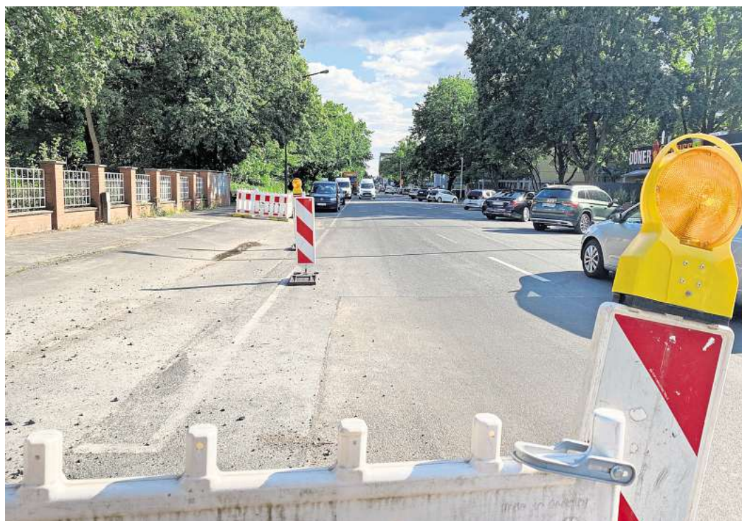
Zwischen Hagenhof und Ehlersstraße: Hier wird in den kommenden Monaten unter anderem die Fahrbahn erneuert. Foto: Katerina Jarlim-Vormeier
