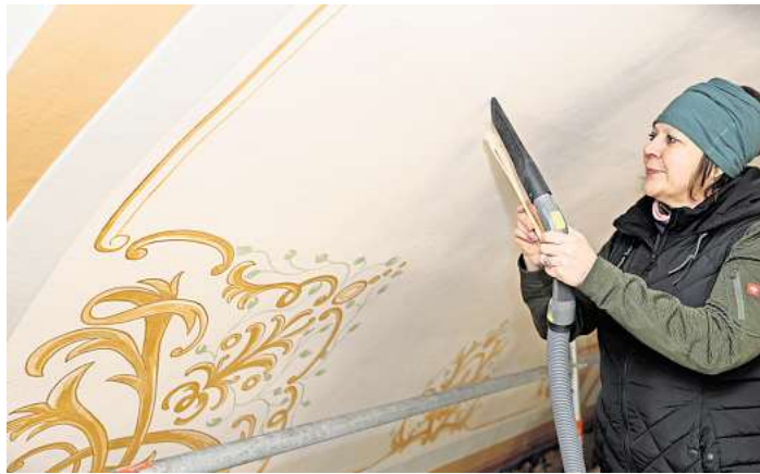
Mit Pinsel und Staubsauger: Restauratorin Ute Tuch befreit die Decke der Engelbostler Martinskirche von Rußpartikeln.
