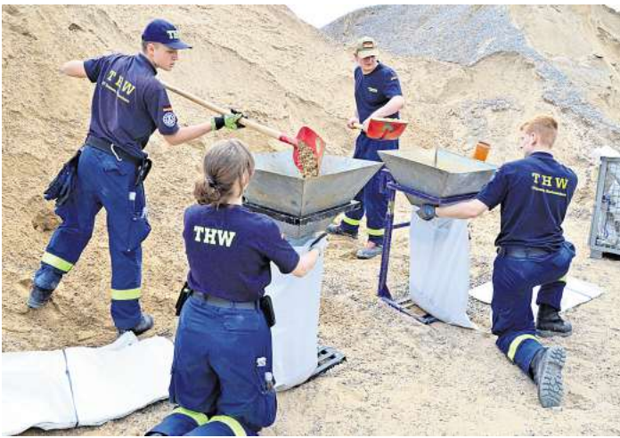
Erste Ausbildungsstation – füllen der Sandsäcke mit einem Trichter. Foto: Pierre Graser
