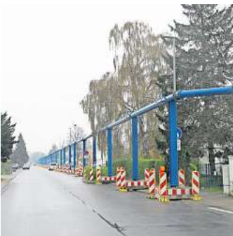
Wird noch benötigt: Durch das blaue Rohr wird derzeit das Schmutzwasser aus Schulenburg-Süd nach Godshorn gepumpt. Foto: Privat
